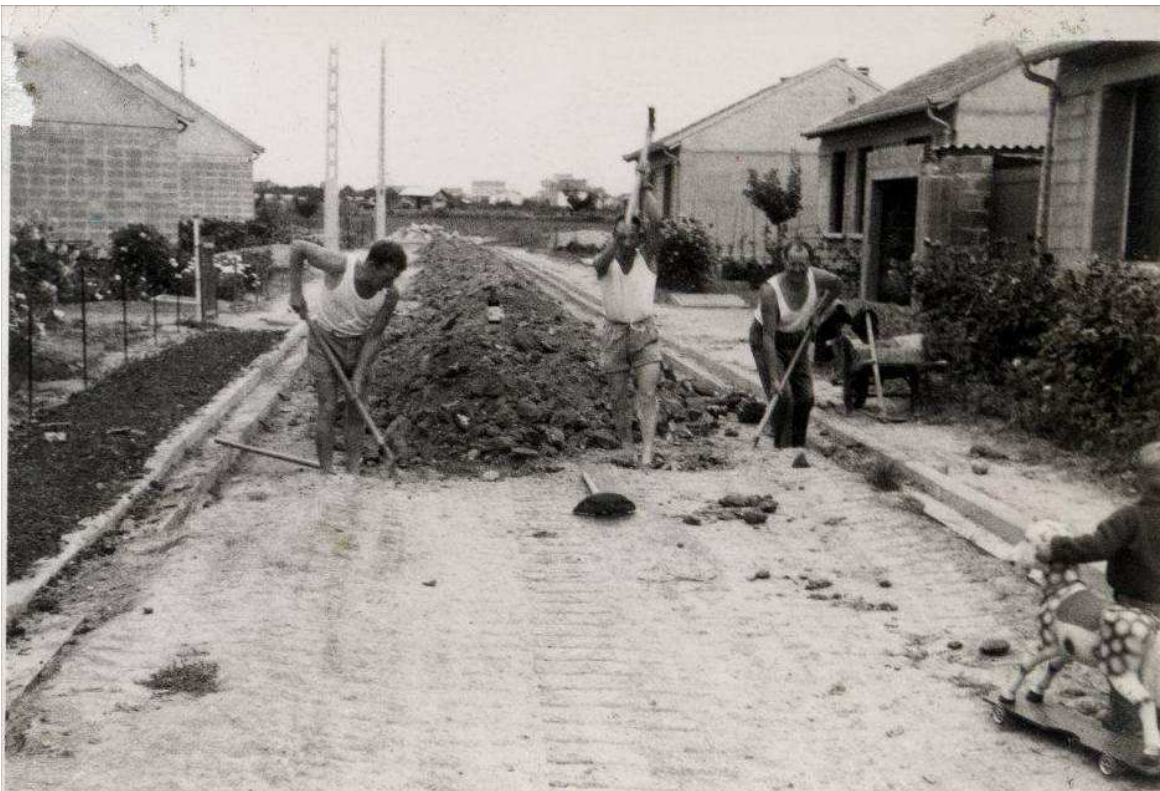
IMAGE 3 – La cité castor des Jardins parisiens en construction - Association des castors du Jardin parisien/cliché centre de ressource de l'écomusée
