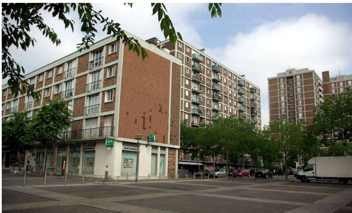
Image 2 – Le quartier Frileuse est la première cité HLM construite à Gentilly. Les premiers locataires y emménagent en 1956. © Ville de Gentilly
